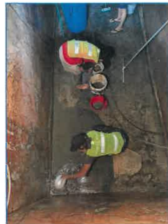
ภาพถ่ายที่ 2.2-5 การล้างทำความสะอาดถึงน้ำใช้
