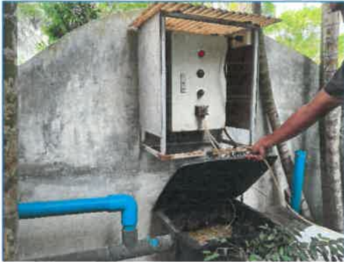
ถังดักไขมันและการจ่ายสารเคมีเพื่อดักจับไขมันเบื้องต้น
