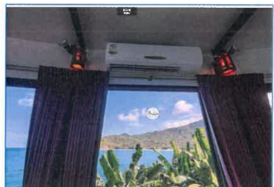
ภาพถ่ายที่ 2.2-17 หลอดไฟฟ้านิต LED อุปกรณ์ไฟฟ้าชนิดฉลากเบอร์ 5
