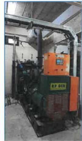
เครื่องกำเนิดไฟฟ้าสำรองของโรงแรม
