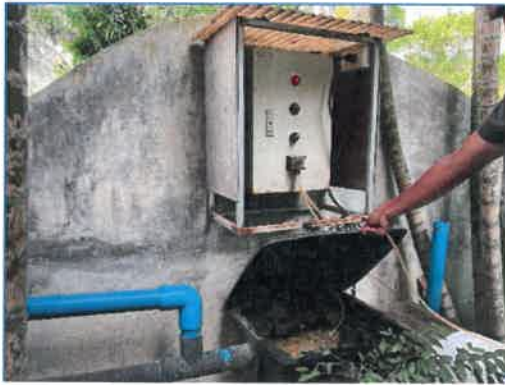
ภาพถ่ายที่ 2.2-8 ถังดักไขมันและการจ่ายสารเคมีเพื่อดักจับไขมันเบื้องต้น
